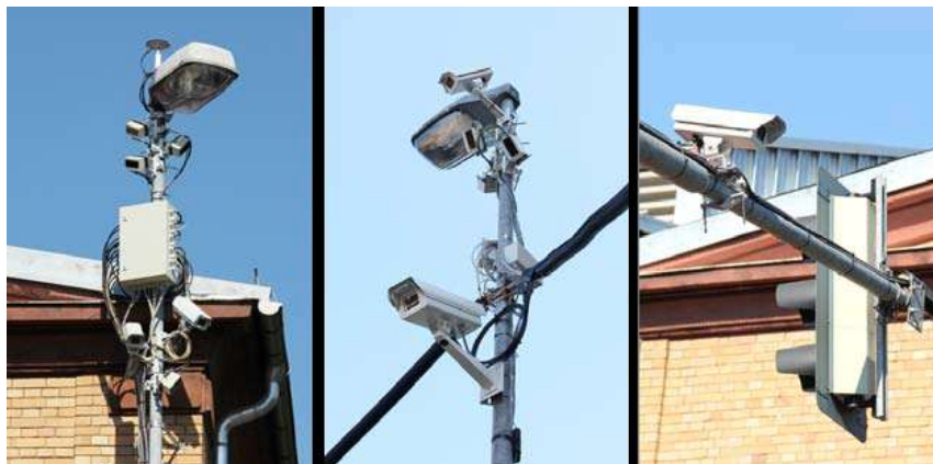
Abbildung 65: Sensormontagebeispiele an der öffentlichen Versuchskreuzung in Aschaffenburg
